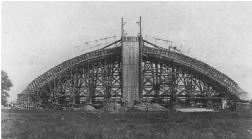
Figuur 6 De bouw van een brug
