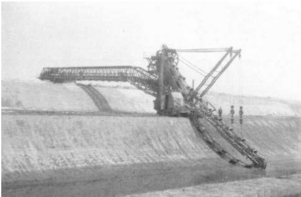
Figuur 4: De excavateur graaft het kanaal in 1932
